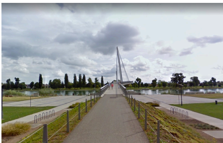
Accès H : Accès passerelle Franco-Allemande accès piéton et cycliste
